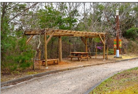
藤棚を森林公園自力で修復！ 壊れていた藤棚を修復しました。
