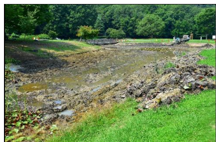
上池の浚渫とスイレンの除去 上池では、スイレンがはびこり 水辺の生きものが活動する 場が無くなっているため、 スイレンと土砂の除去を行 いました。
